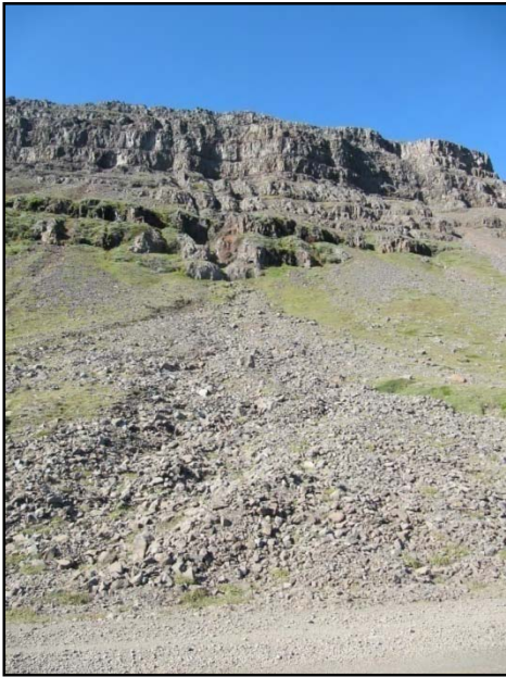
Mynd V.31. Farvegur 30. Virk skriðukeila, náð allavega niður að vegrás. Ekki náð yfir veg nýlega, en þó líklegt til að gera slíkt, enda áberandi skriðukeila neðan við veg.
