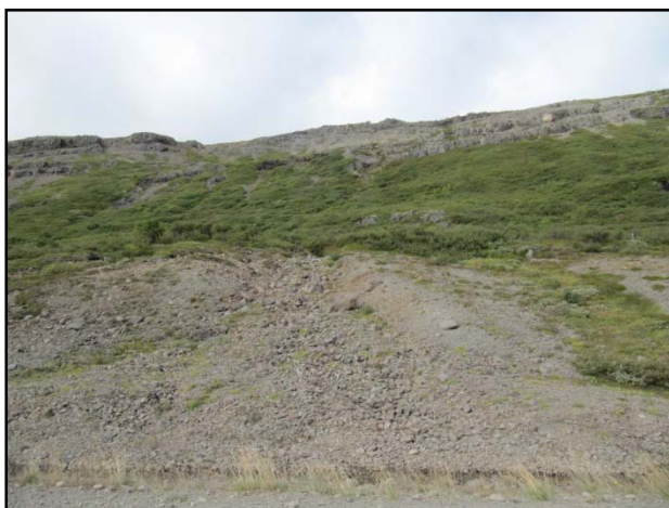
Mynd V.78. Farvegur 80. Hér hafa skriður náð að vegrás og farið þar með yfir stall sem annars ver veg fyrir skriðum í þessari hlíð.
