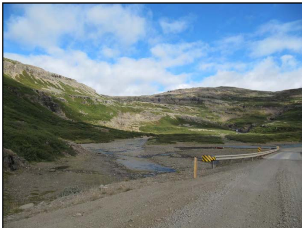
Mynd V.74. Farvegur 75. Kjálkafjarðará, brúin yfir ána virðist traust og taka við því sem áin býður upp á.
